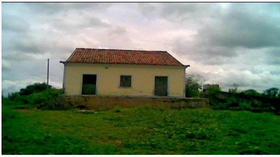
Figura 4: Casarão das Biringa, décadas atrás comunidade de Lagoa de pedra, Ipanguaçu-RN, Brasil.
